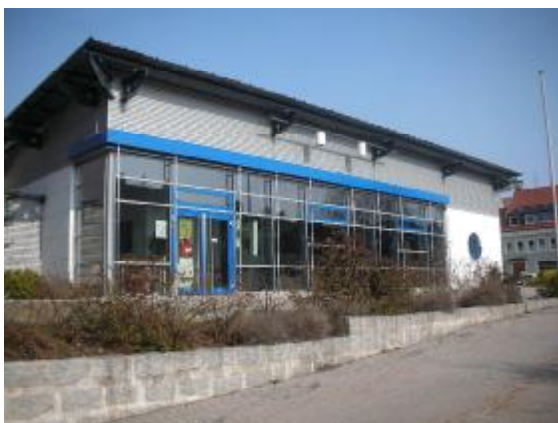
Textilmuseum Neubau im rückwärtigen Bereich
