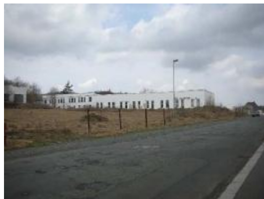
Außengelände Witt & Bob, nordwestwärts
